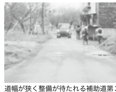
道幅が狭く整備が待たれる補助道第3号線
