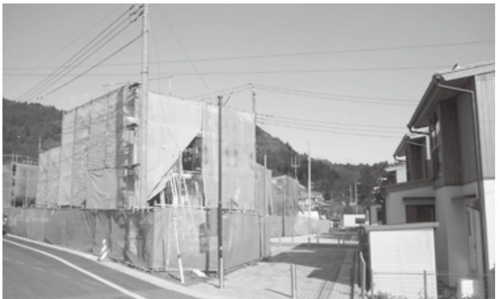
建設中の8棟が完成すると全22棟となる新井町営住宅
