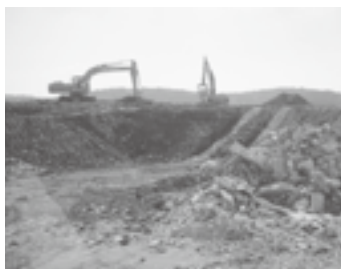
被災住宅等の廃材置き場
