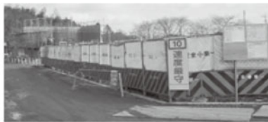
建設が始った（仮称）平井宮本総合福祉センター
