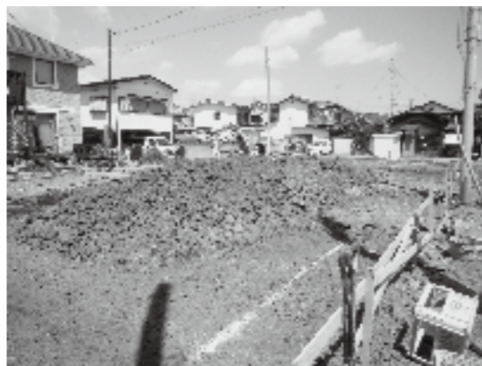
工事が始まった(仮称)新東本宿住宅
