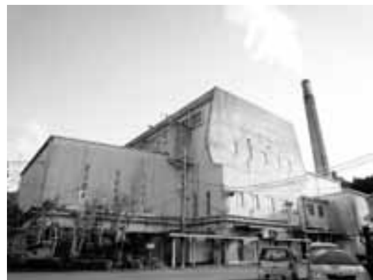
老朽化している西秋川衛生組合の施設
