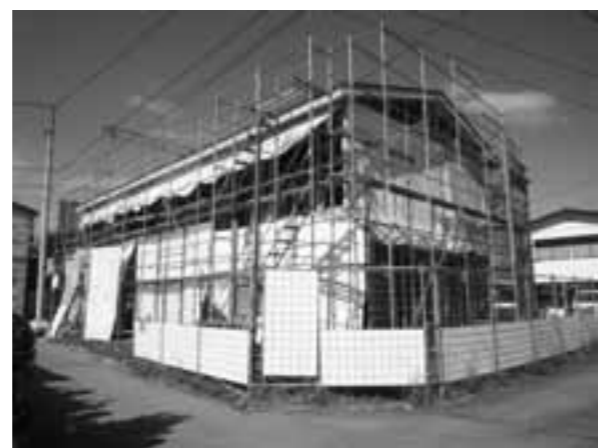
建設中の町営住宅 (I期工事)
