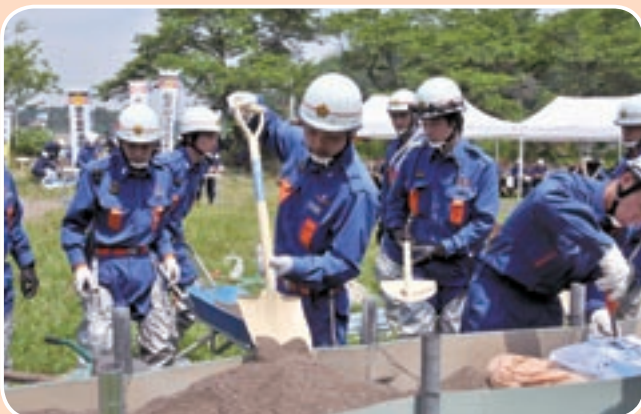
秋川流域水防訓練で鋼板工法を行う消防団員
