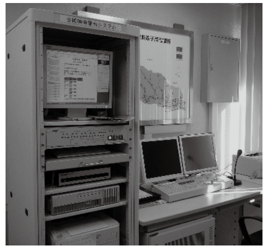
日の出町防災行政無線 (デジタル化された操作卓)
