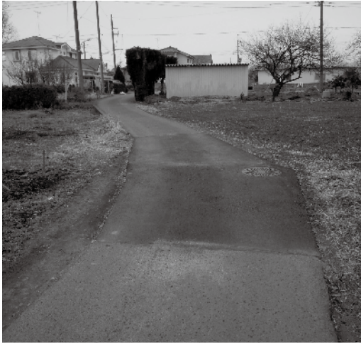
補修された生活道路
