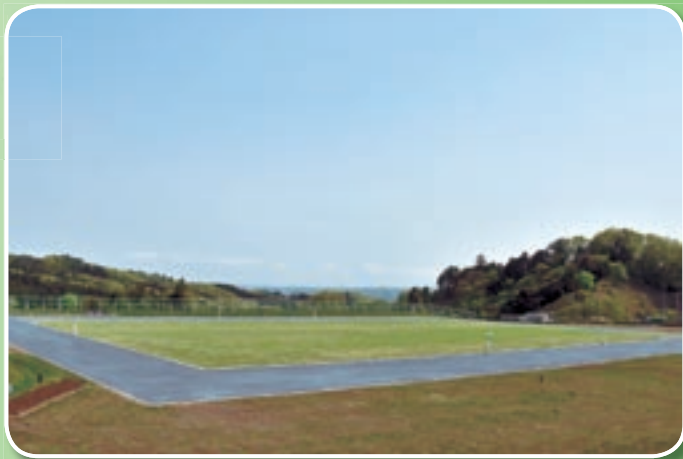
完成したサッカー場 道路から東を望む
