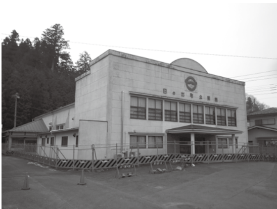
解体前の公民館 新公民館今秋完成予定
