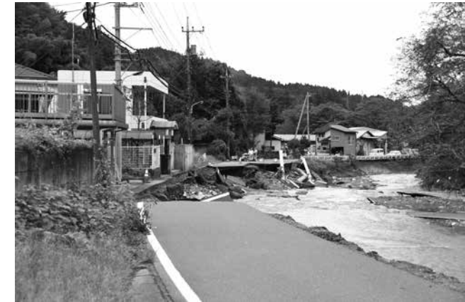
台風19号洗掘現場
