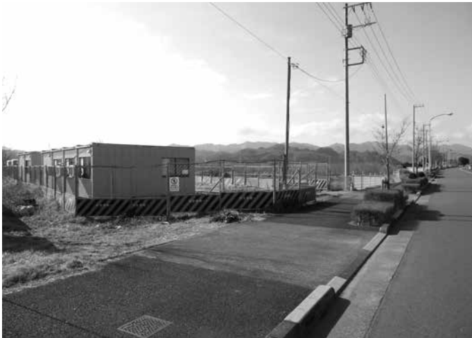
工事が停止されている 武蔵引田駅北口土地面整理事業
