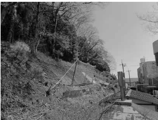
施工中の大久野小学校裏の急傾斜地対策工事
