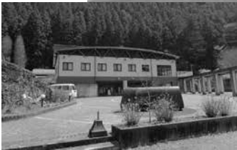
梅ヶ谷トンネル開通を控え環境整備が求められる
