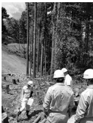
玉の内資材置き場への現場視察
