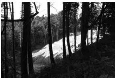
玉の内地区盛土現場
