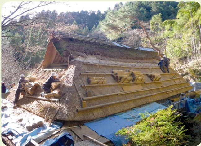
茅葺屋根の葺き替え作業
