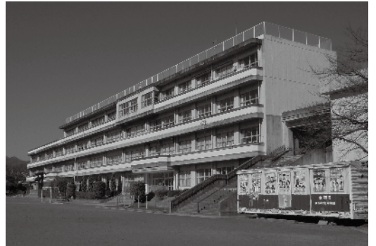
一部外壁の改修等を実施した本宿小学校校舎
