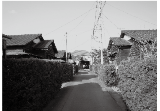
建替え予定の東本宿町営住宅
