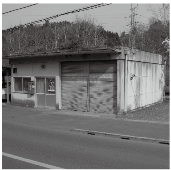
老朽化した第4分団第3部詰所
