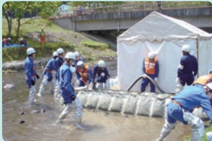
▲ 訓練想定地に土のう堤を築造
