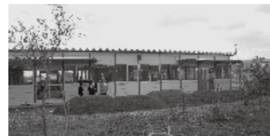
建設中の仮園舎（さくらぎ保育園）
