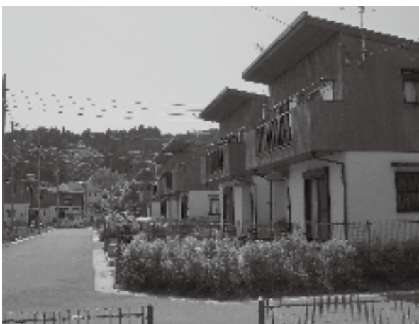
整備された新井町営住宅
