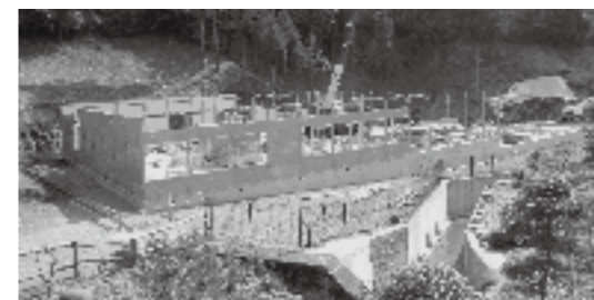
建設中の仮園舎（宝光保育園）
