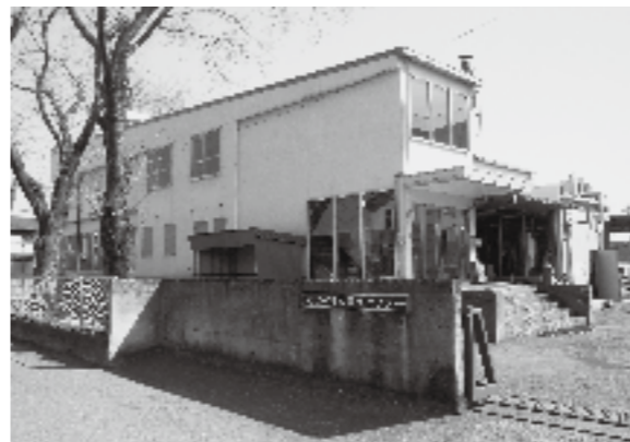
耐震補強予定の学校給食センター
