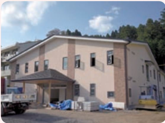
工事中の新公民館
