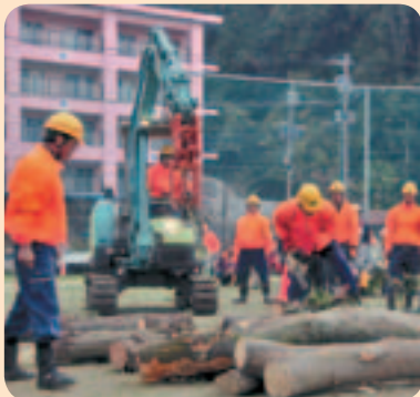
西多摩緊急災害協力会 道路啓開作業
