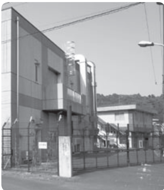
大久野浄水所（入口から撮影）
