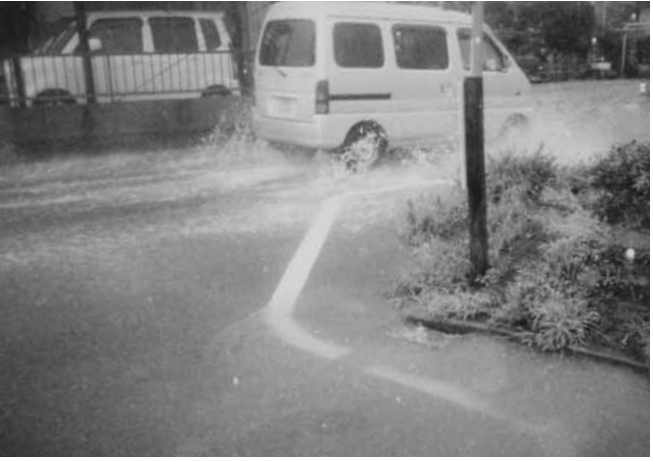
降雨時には排水の間に合わない道路
