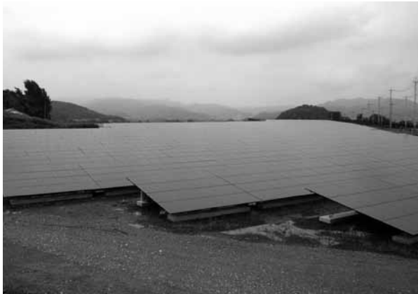
群馬県太田市のメガソーラー発電施設 (太陽光パネル)
