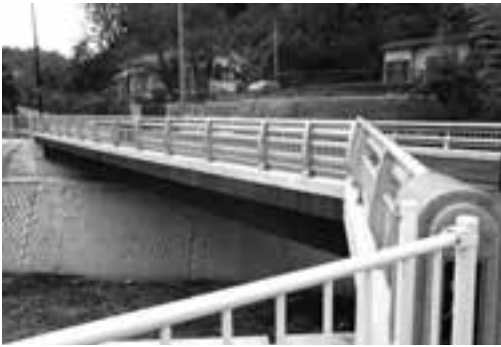
架け替えられた御殿橋
