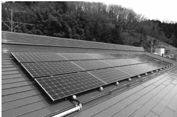
太陽光発電システム
