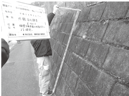
擁壁調査の様子
