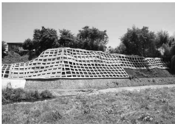
平井川の防護工事
