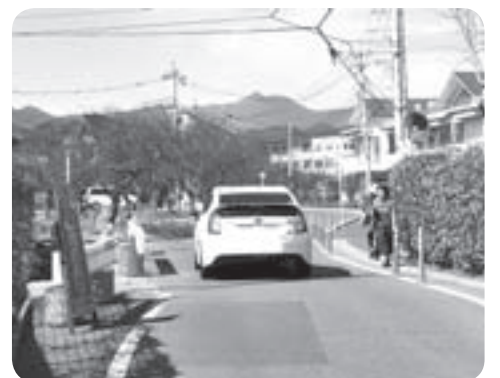
拡幅及び歩道の整備を行う補助道第3号線
