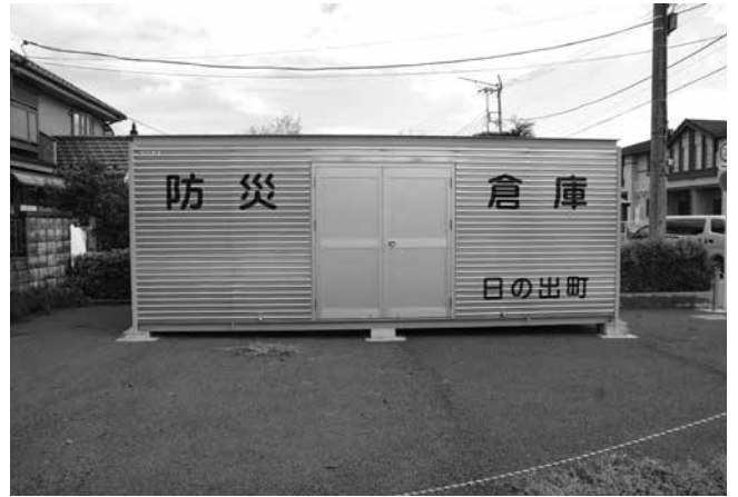
防災備蓄品などが収納されている防災倉庫
