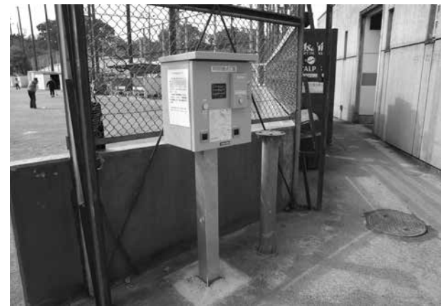
各種団体に利用されている市民グラウンド（照明点灯盤）
