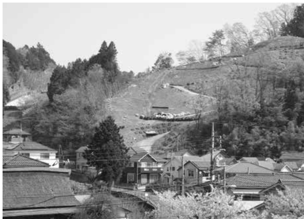
太陽光発電施設設置工事の状況
