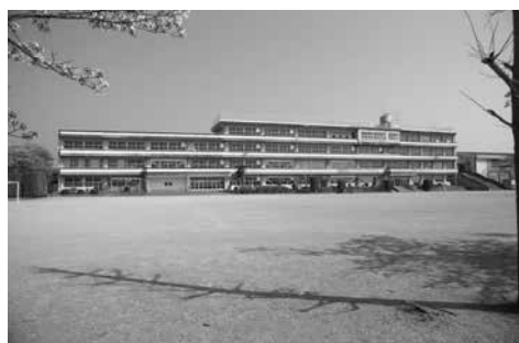
改修計画が進む本宿小学校
