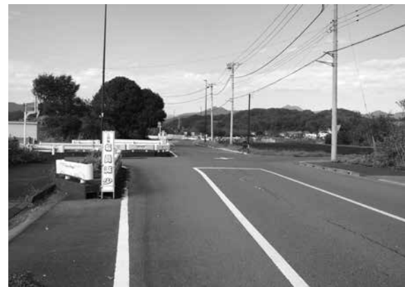
道路整備中の都道165号線
