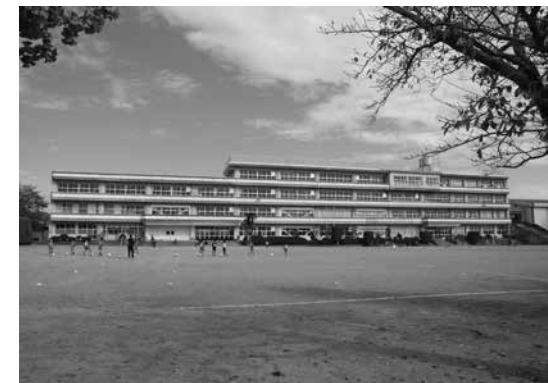
改修計画が進む本宿小学校校舎
