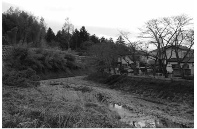
河川映像監視システムの設置予定場所付近
