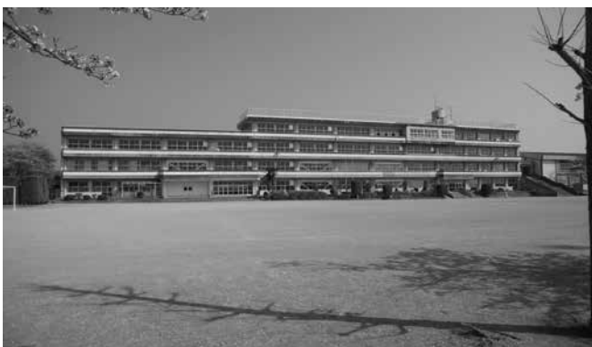
改修計画が進む本宿小学校
