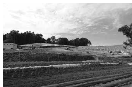
太陽光発電施設(鳩山町)
