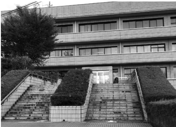
手すりのない庁舎南側外階段
