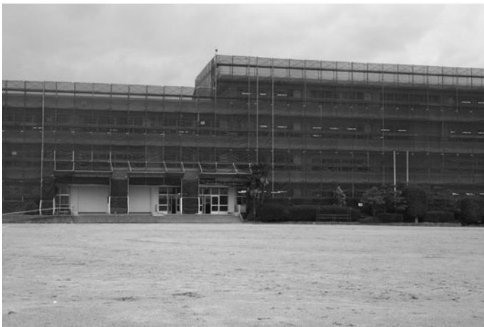
本宿小改修工事の様子
