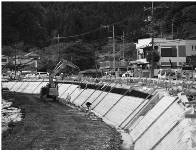
復旧が進む都道184号線
