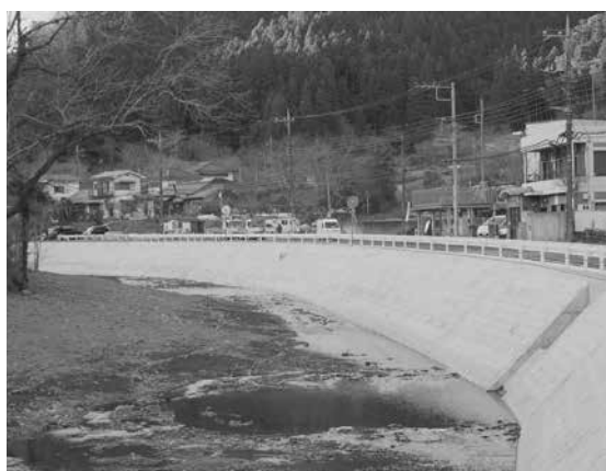
護岸の復旧が完了した都道184号線
