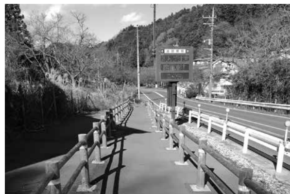
都道251号線北大久野橋付近に 設置された仮設歩道
