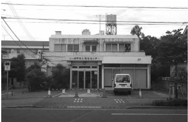
解体が予定されている旧平井老人福祉センター
