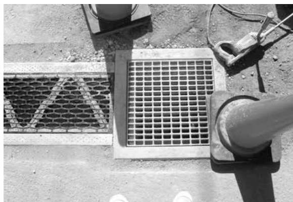
冠水箇所へ設置中の横断側溝と集水樹
