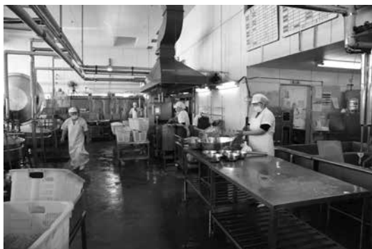
老朽化が進む学校給食センター
