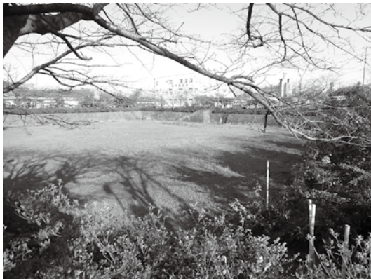
大雨時重要な役割を担う調整池
