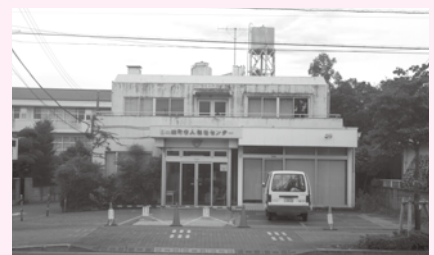
解体される旧平井老人福祉センター
