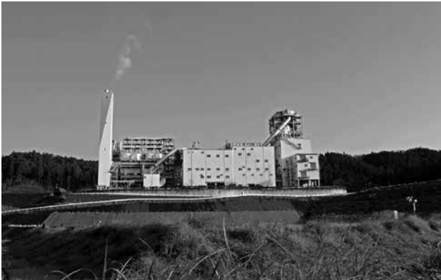
エコセメント化施設
