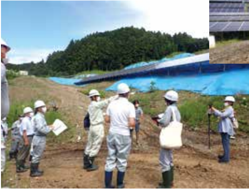
雲龍寺の太陽光発電 施設建設現場
