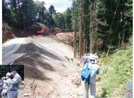
二ツ塚の残土埋立て現場
