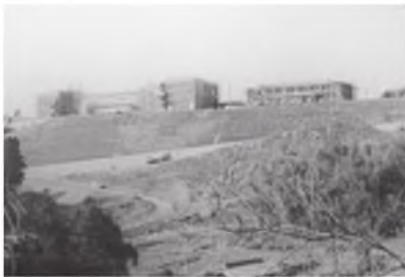
文化の森第一期造成工事/昭和56年 文化の森第一期造成と平井中学校建設工事
