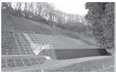
復旧工事が終了した日の出団地北側法下
