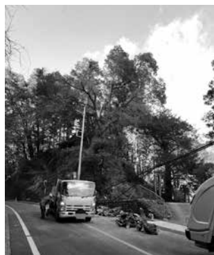
町内で発生した強風による倒木処理現場
