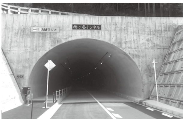
梅ヶ谷トンネル
