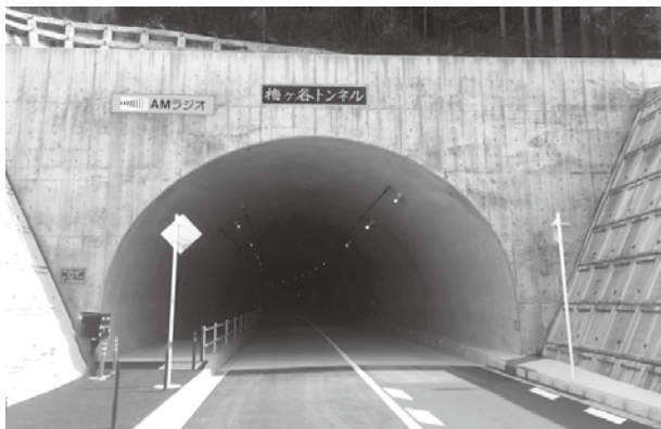
梅ヶ谷トンネル
