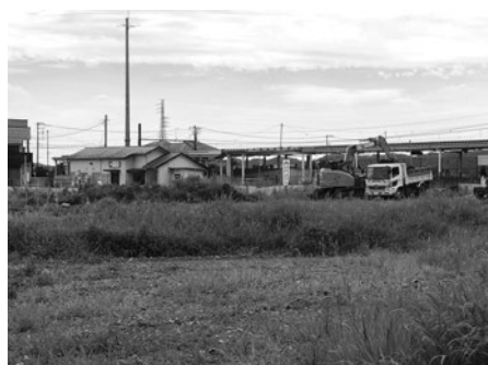
武蔵引田駅北口再開発現況
