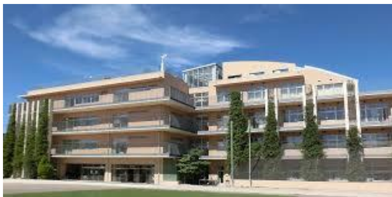
杉並区立天沼小学校校舎（学校ホームページより）
