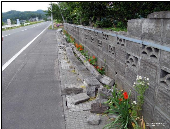
図 4-1 地震により倒壊したブロック塀
