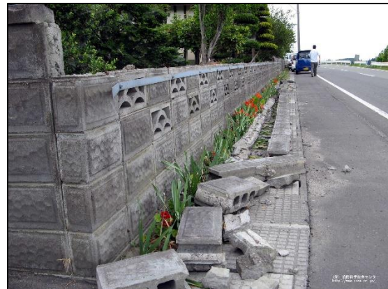
図 4-1 地震により倒壊したブロック塀
