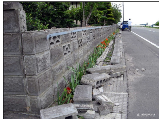
図4-1 地震により倒壊したブロック塀
