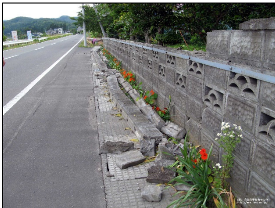
図4-1 地震により倒壊したブロック塀
